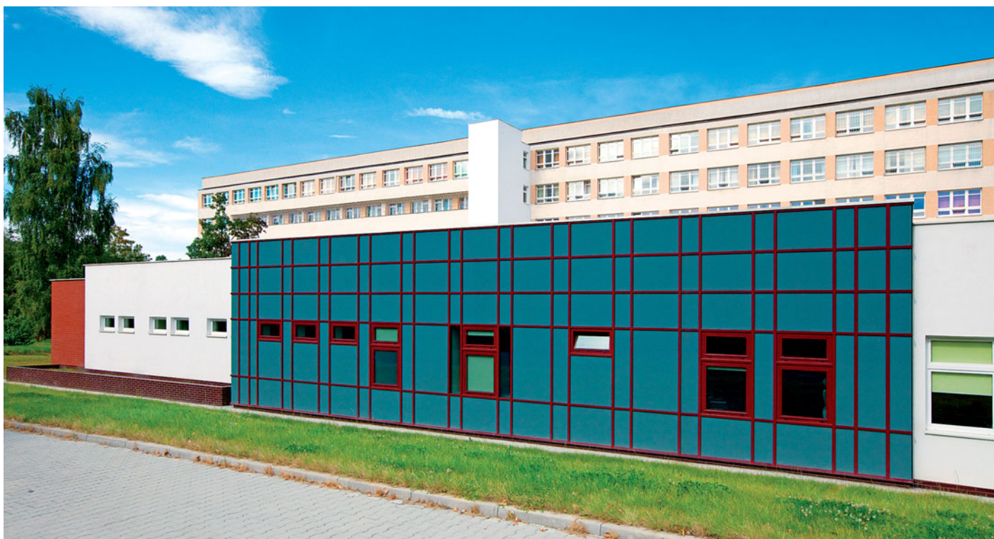
Szpital Powiatowy, Limanowa
